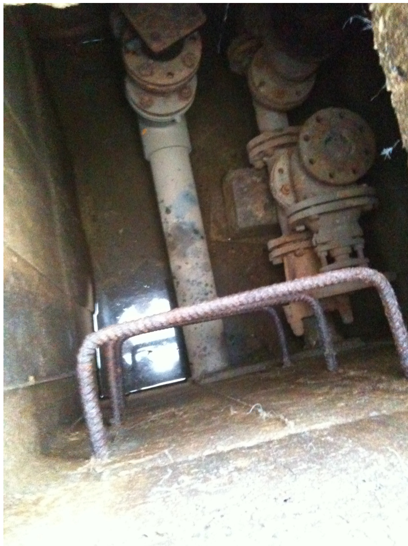
Rete idrica – pozzetto esistente – foto 1
