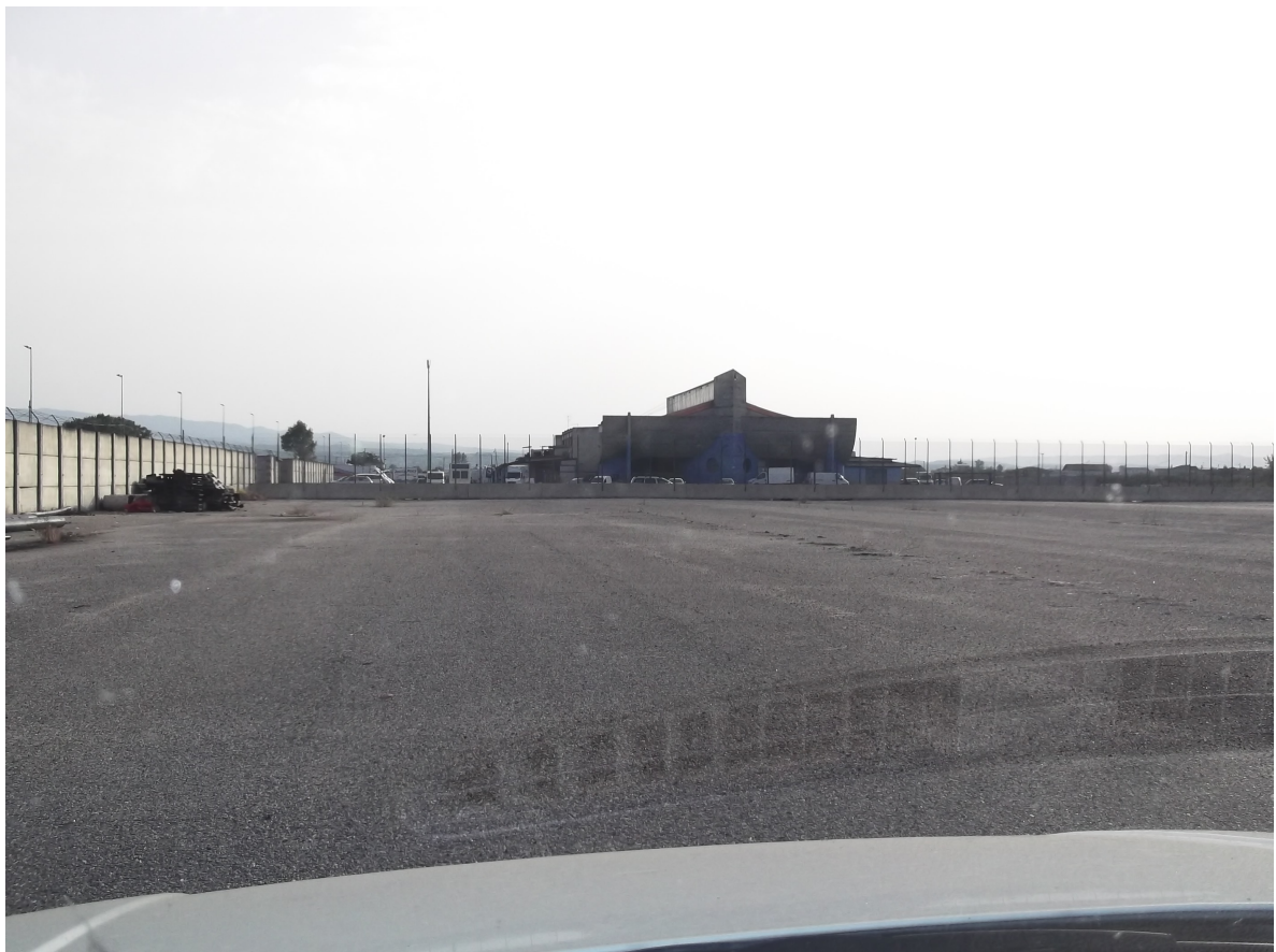
Rete acque bianche – zona impianto di trattamento acque di prima pioggia – foto 12
