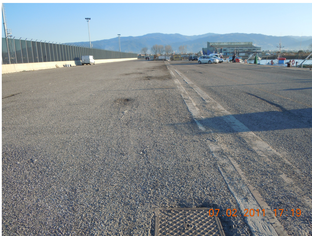
Rete antincendio – zona banchina 6 – foto 2
