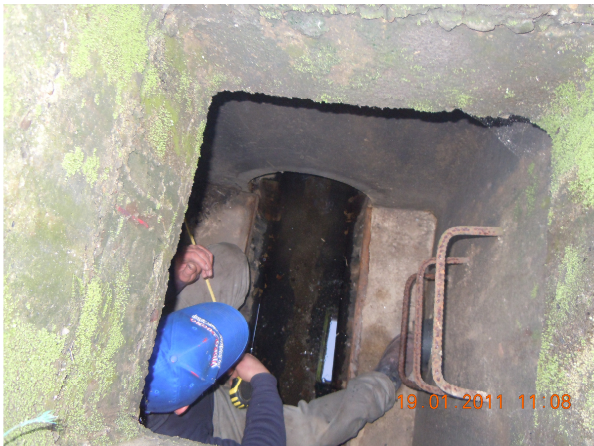
Rete acque bianche – pozzetto esistente – foto 1
