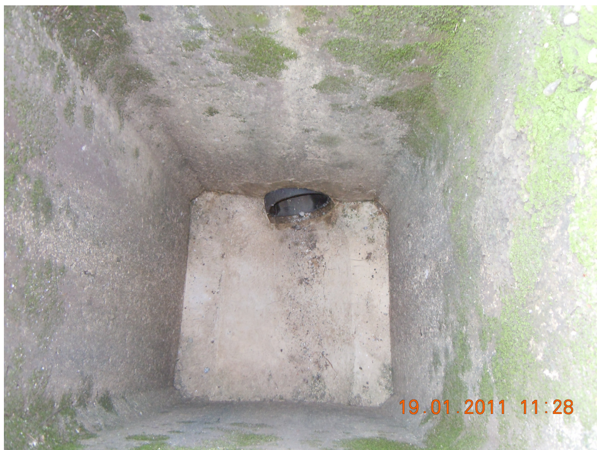
Rete acque bianche – pozzetto esistente – foto 2
