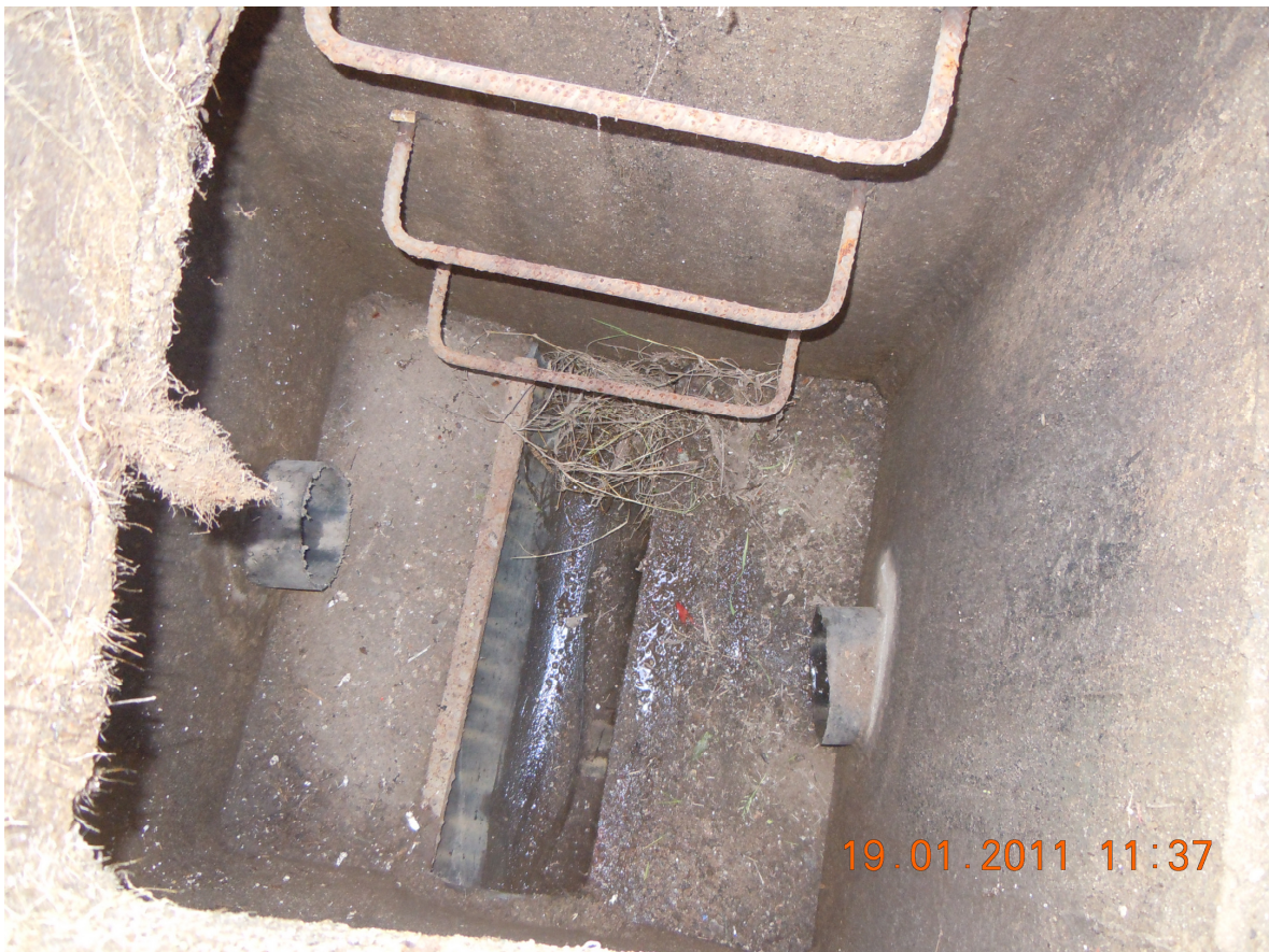
Rete acque bianche – pozzetto esistente – foto 4
