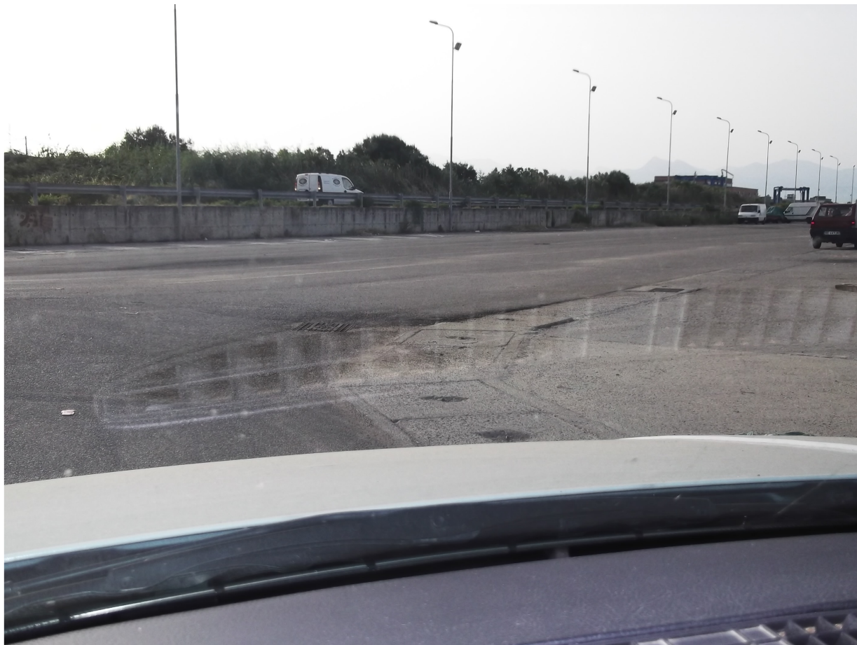
Rete antincendio – zona banchina 7, cunicolo esistente – foto 3
