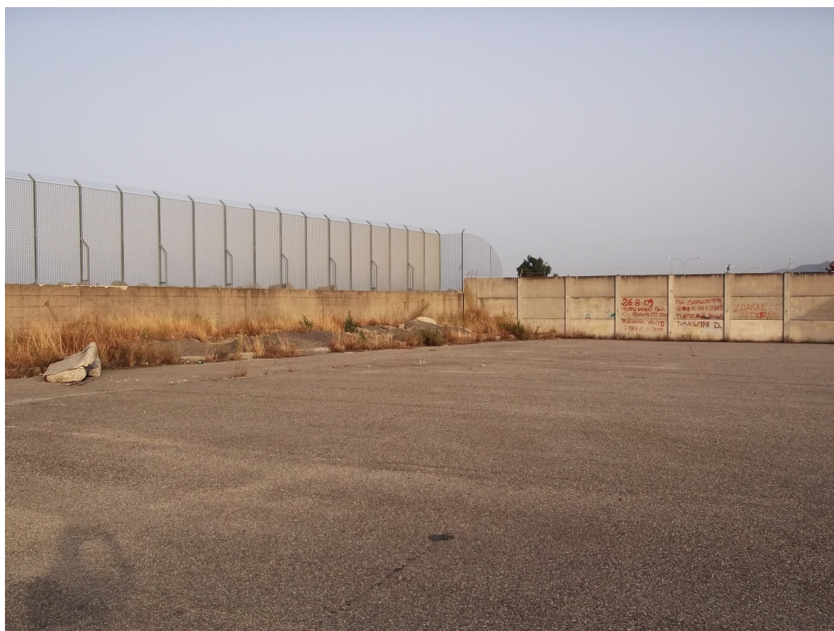
Rete antincendio – zona banchina 1, zona gruppo serbatoi e pompe – foto 6
