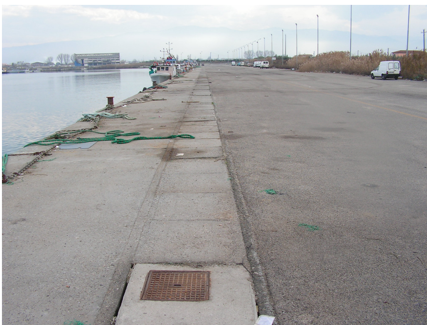
Rete idrica - cunicolo esistente – foto 2
