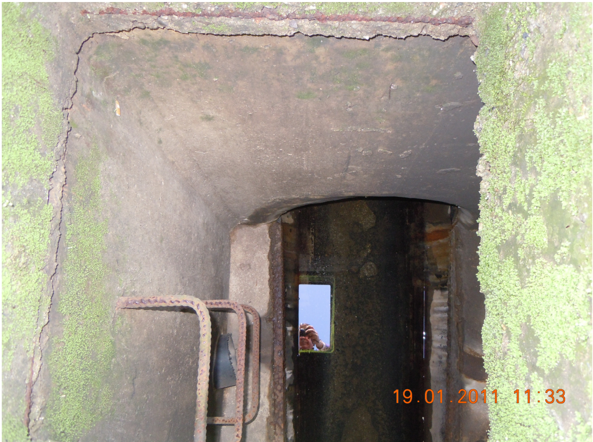
Rete acque bianche – pozzetto esistente – foto 3
