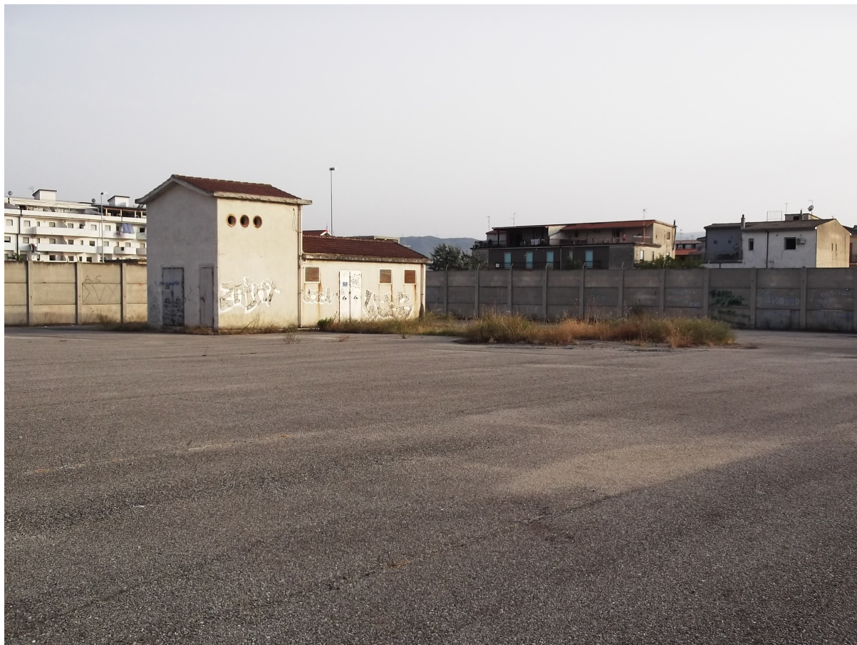
Rete antincendio – zona banchina 1, zona gruppo serbatoi e pompe – foto 5
