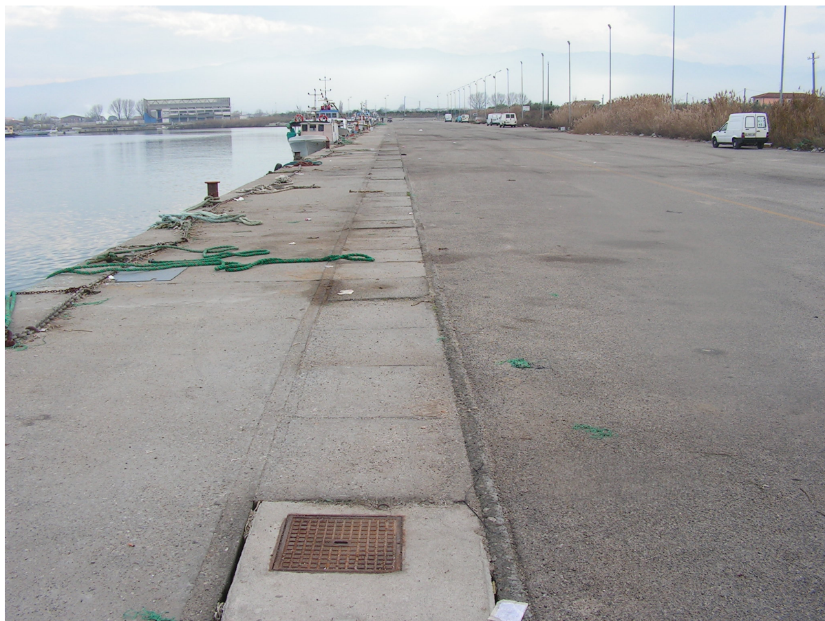
Rete antincendio – zona banchina 8, cunicolo esistente – foto 4
